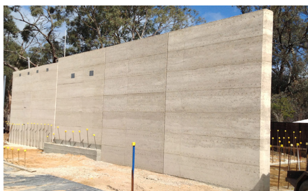
Esempio di un muro realizzato in rammed earth concrete
